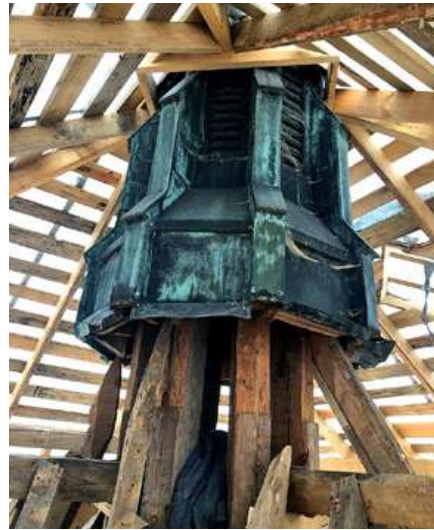
Remont więzby dachowej kaplicy Krzyżanowskich
