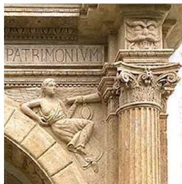
Fragment portalu pałacu w Jazłowcu (po renowacji)
