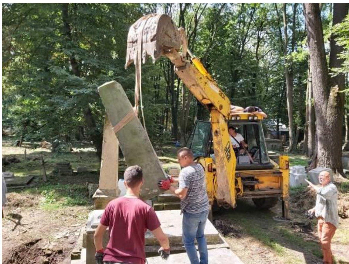
Fot. 24 Ustawianie elementów pomnikowych z pomocą koparki (Dominik, Sebastian, pan Włodzimierz). Bardzo ciekawa scenka (?) – na dachu koparki „zalegają” dwaj synowie operatora (???!!!) – szok! Widać u nich tak można(?)
