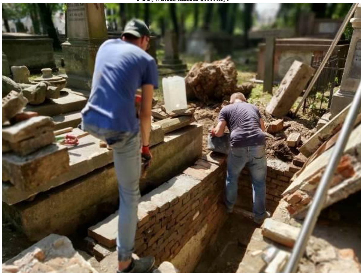
Fot. 12 Grobowiec Łazarza w trakcie rekonstrukcji (Sebastian w dole, Kacper i Maciej (poza kadrem) pomagają
