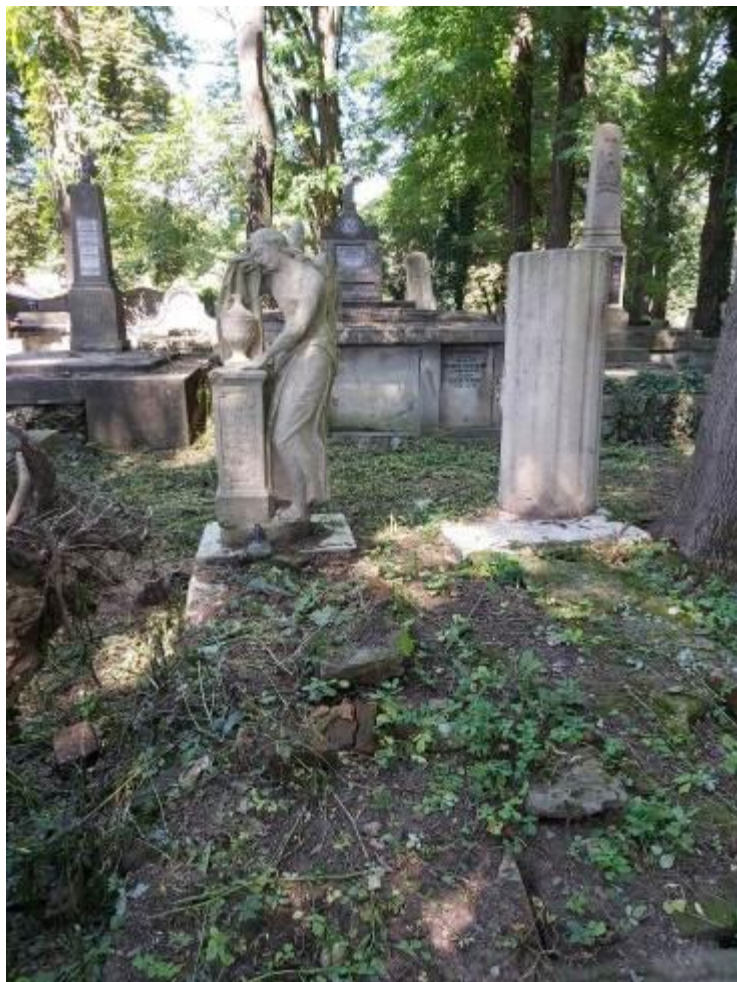
Fot. 15 Mogiła Josephy Lutz i jej 3-ga dzieci przed działaniami remontowymi (rozpadające się przykrycie komory grobowca, wrastająca w strop ceglany roślinność, która rozsadza korzeniami sklepienie ceglane)
