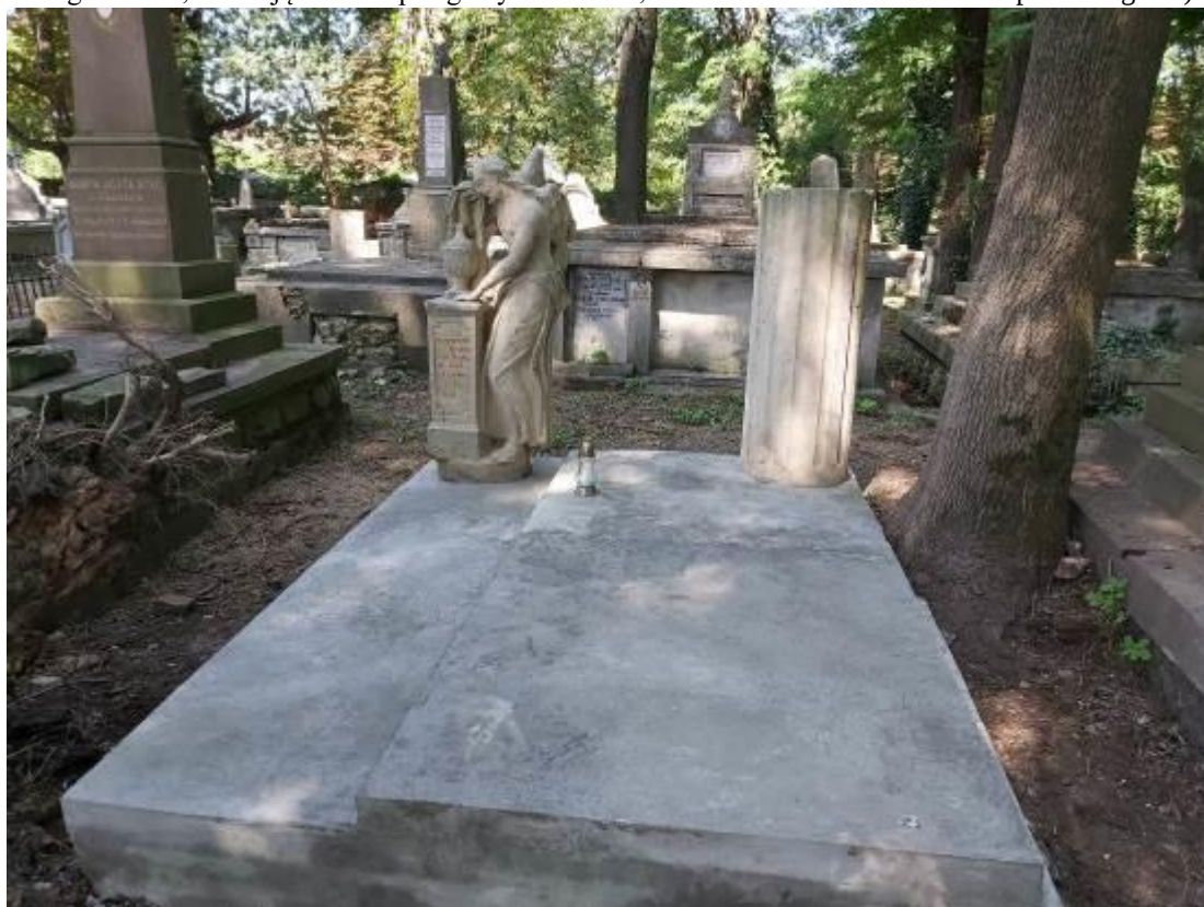
Fot. 16 Wykonana płyta betonowa zabezpieczająca grobowiec, odnowione i uzupełnione napisy, uporządkowane otoczenie mogiły
