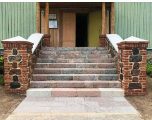
Kamienne schody do kościoła w Powiewiórcie, przed konserwacją i po jej wykonaniu
