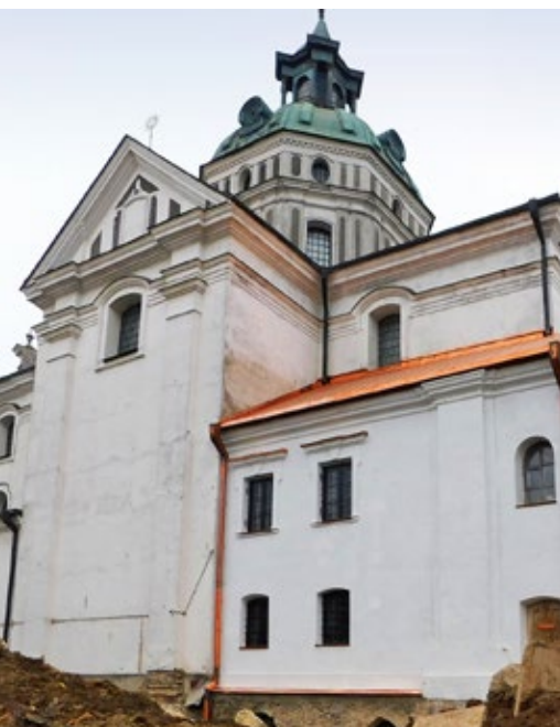
Boczna nawa kościoła w Berdyczowie, po remoncie dachu
