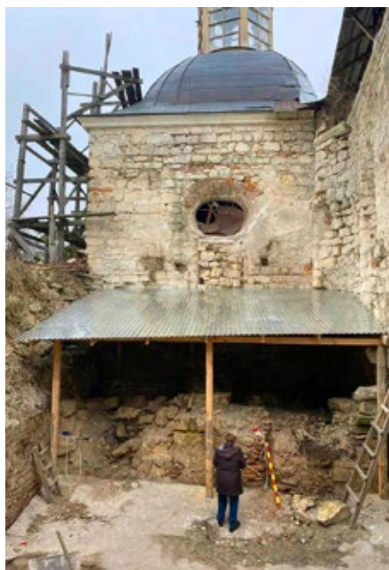
Prace porządkowe przy kaplicy Sieniawskich w Brzeżanach
