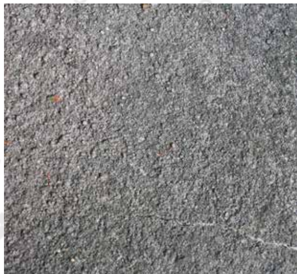
IL. 54 Beton z wyraźnie widocznymi ziarnami piasku
