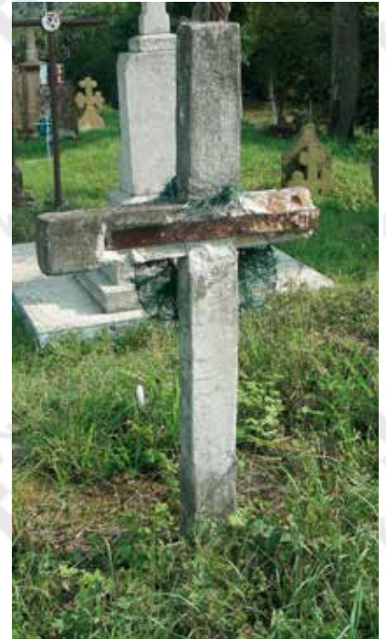
IL. 38 Armatura nagrobka wykonanego z betonu (żelbet)
