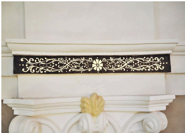
Prace konserwatorskie przy drewnianym pasie na gzymsie w kolegiacie w Ołyce
