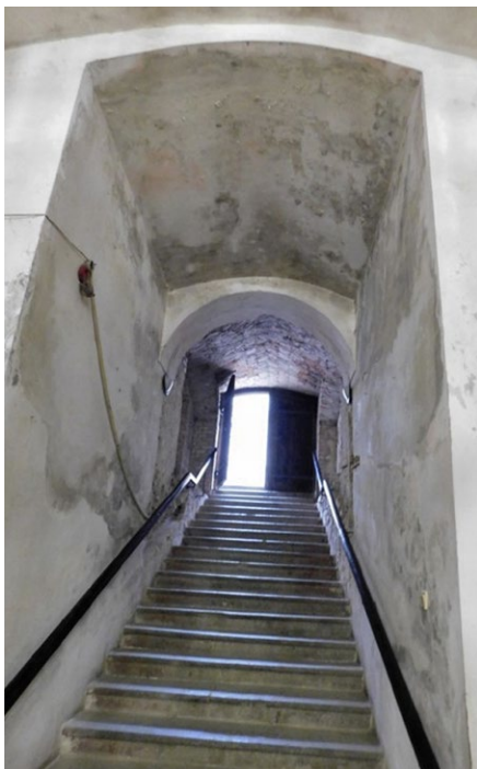
Prace konserwatorskie w kościele dolnym w Berdyczowie
