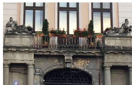
Mars i Wenus na portalu budynku przy ul. Teatralnej
