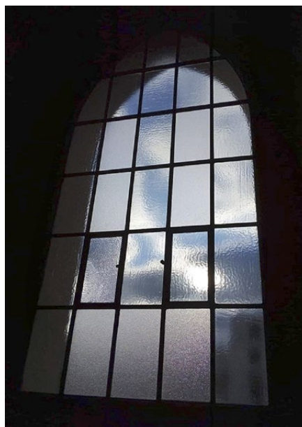
Okno w wieży południowej katedry łacińskiej we Lwowie po konserwacji
