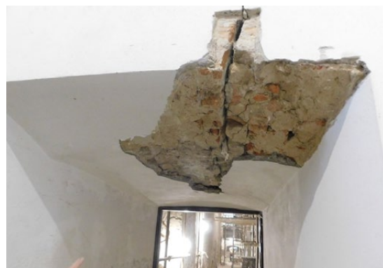
Prace renowacyjno-zabezpieczające w kościele dolnym zespołu klasztorного karmelitów bosych w Berdyczowie
