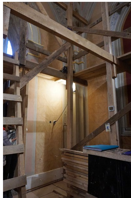
Prace konserwatorskie w kościele pw. św. Antoniego we Lwowie
