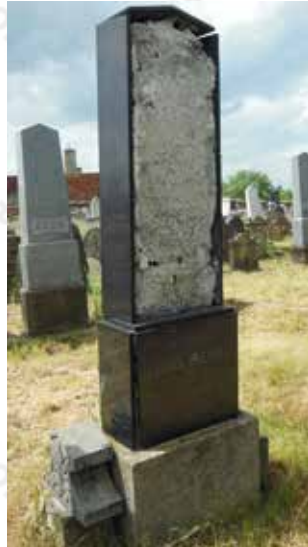
40 IL. Betoninis antkapis (obeliskas ant dvilapčio cokolio), apkraštuotas akmens plokštėmis
