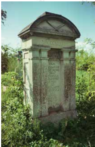
21 IL. Edikula su dviem poromis kaneliuruotų piliastų ant cokolio, piliastrai laiko supaprastintą antablementą su frontonu
