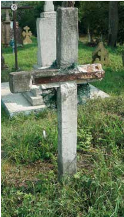
38 IL. Betoninio antkapio armatūra (gelžbetonis)
